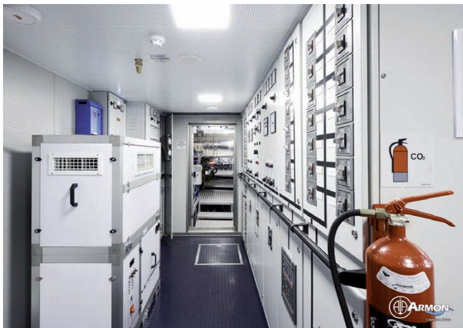
➤ Cuadros principales y auxiliar, eléctricos.
