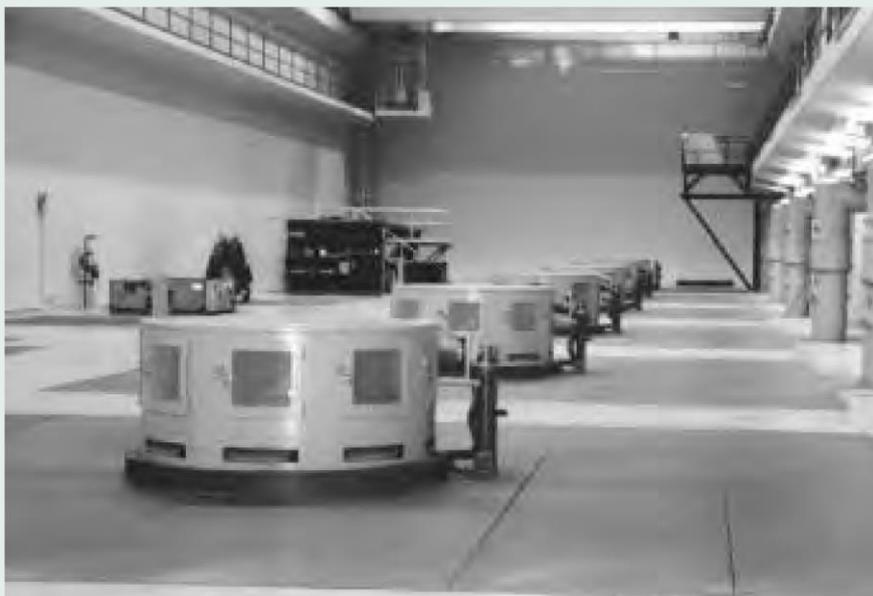
Шесть насосов Hitachi мощностью 60 000 л. с. на насосной станции Navasu, Аризона.
