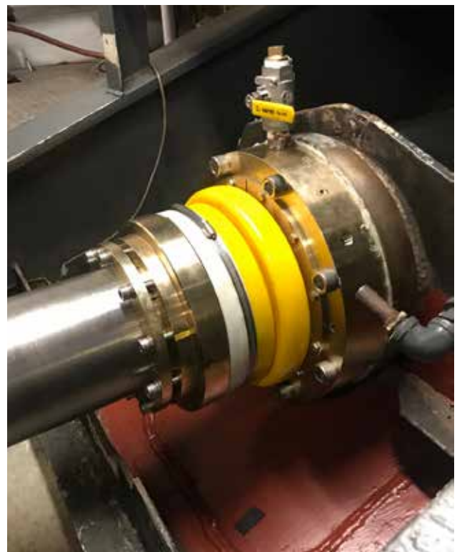
Se indicó y se instaló un nuevo sello TG100
