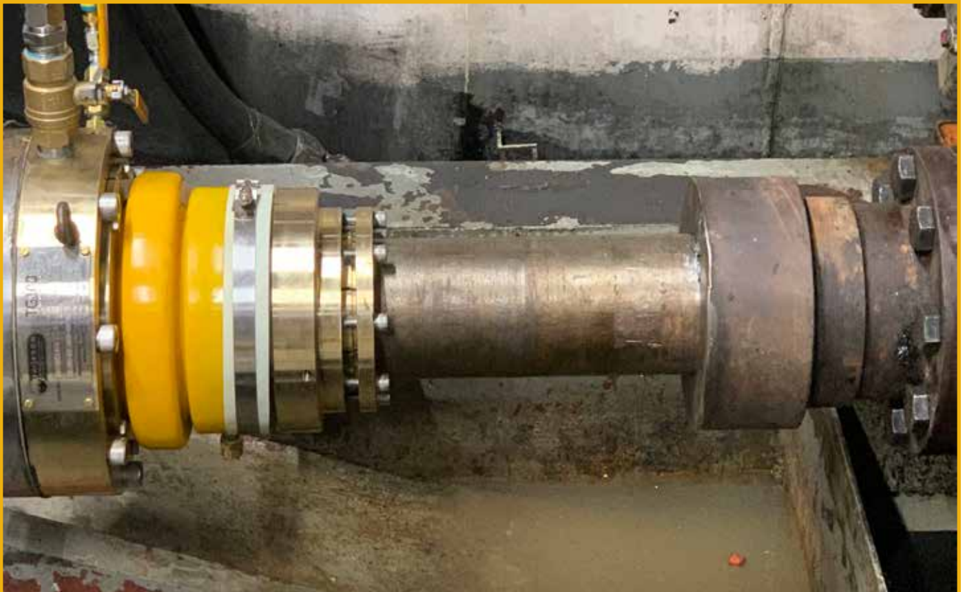
Nuevo sello de emergencia TG100 instalado al Jennifer S.
